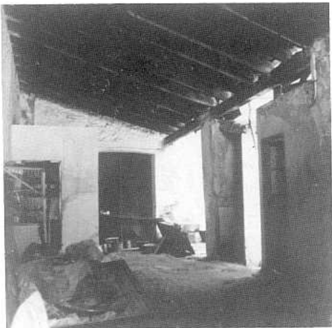
Afectada por posteriores modificaciones, la "cuadra de la izquierda" no conserva la grandiosidad de la opuesta.
