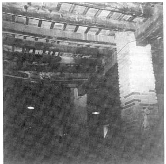
El techo, muy elevado, mantiene su estructura original.
