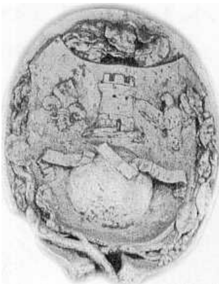
L'ESCUT DE LA FAMÍLIA MUNDINA QUE LLUEIX A LA FAÇANA DE LA SEUA CASA PAIRAL AL CARRER MAJOR.
